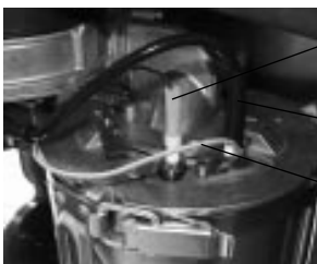
Ionizační kabel Zapalovací potrubí Masové vedení
