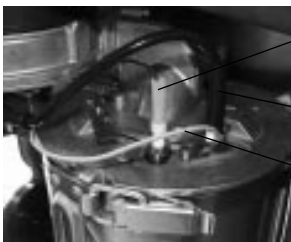
Ionisations- kabel Zündleitung Masseleitung
