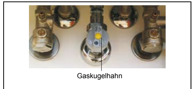
Bild: Absperreinrichtungen
