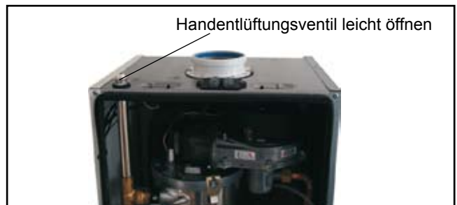
Bild: Manuelles Entlüftungsventil
