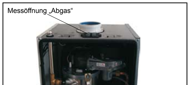
Bild: Abgasmessung bei geöffnetem Gerät
