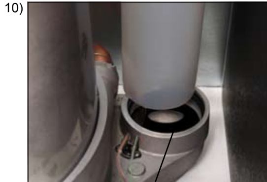
Дроссельная заслонка в дымовой трубе
