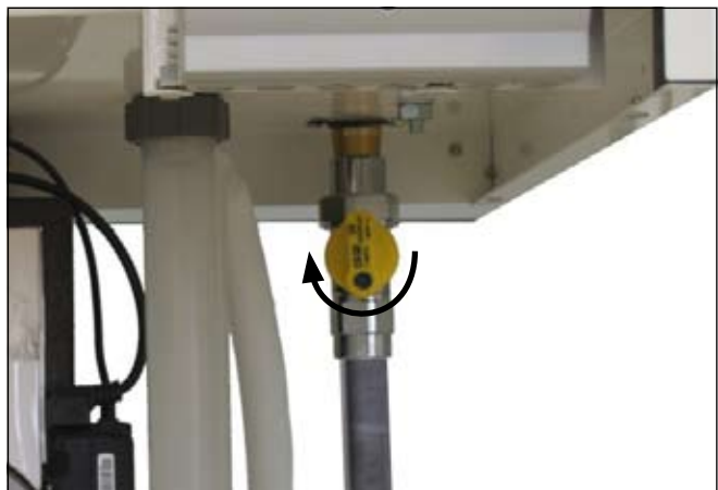
Bild: Gasanschluss Gefahr von Vergiftung und Explosion durch ausströmendes Gas
