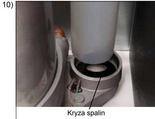
10) Kryzę spalin Ø 53 mm włożyć w wannę kondensatu i ponownie wsunąć rurę spalinową.
