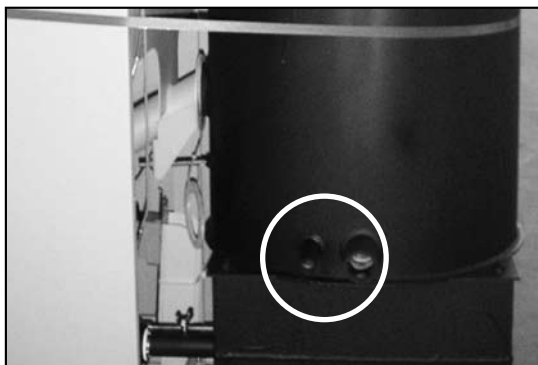
Abb. 09 Befüll- / Entleeranschluss BPH35, Anschluss 1/2 Zoll für KFE Hahn
