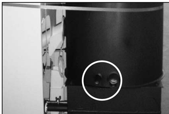
Abb. 11 Befüll- / Entleeranschluss BPH35, Anschluss 1/2 Zoll für KFE Hahn
