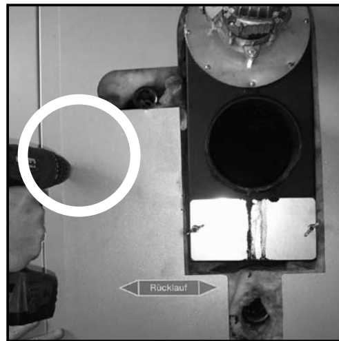
Abb. 52 Befestigung der Rauchkastenabdeckung (Rückseite) mittels Akku-Schrauber & mitgelieferter Schraube.
