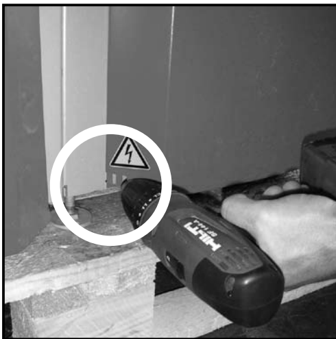
Abb. 51 Befestigung der Behälterverkleidung mittels Akku-Schrauber & mitgelieferter Schraube.
